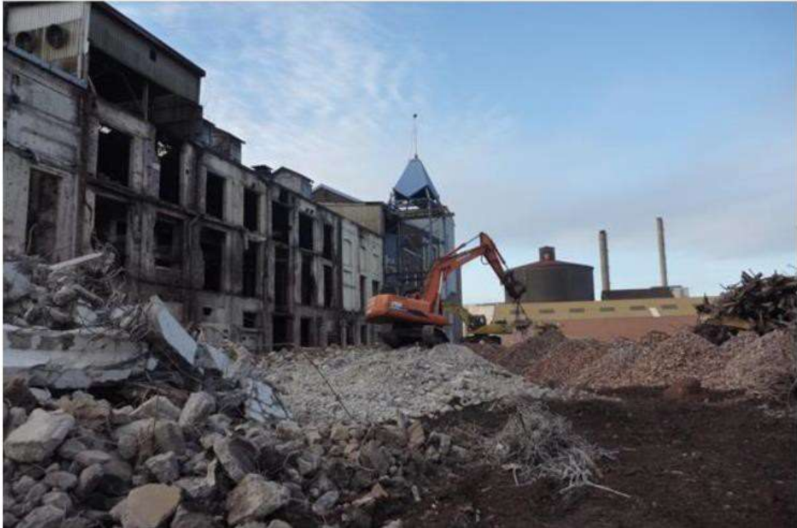
Démolition du Site STORA ©CMMO
