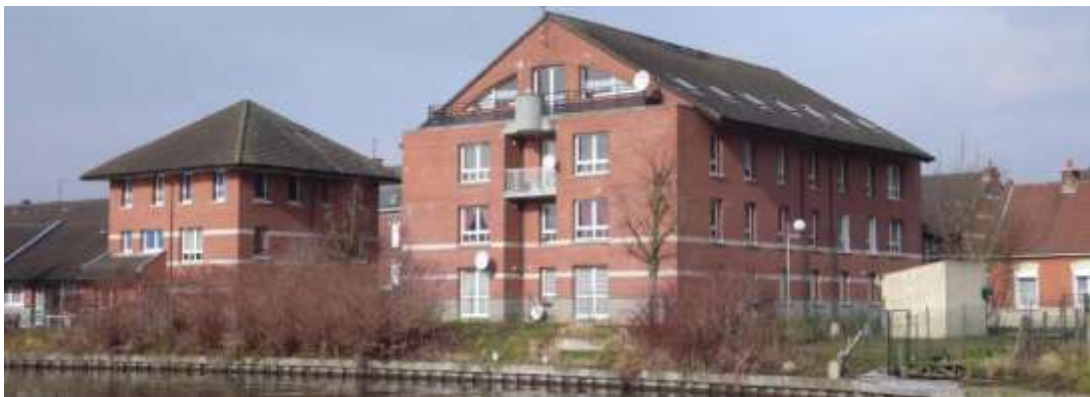
Immeubles à Brebières ©TSC
