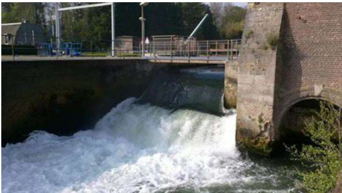
Moulin de Corbehem transformé en centrale hydroélectrique ©CCOM
