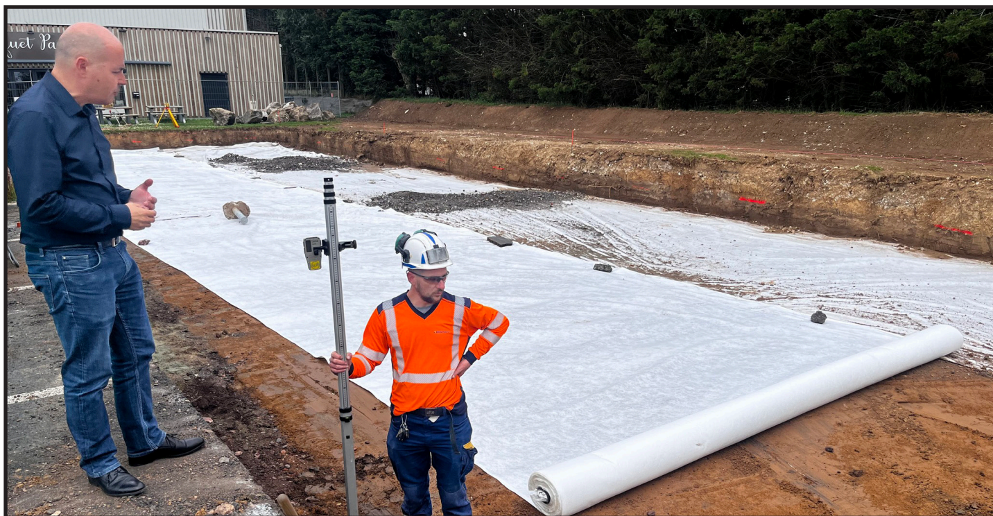
Le Maire Lionel David en visite du chantier des cellules commerciales Route Nationale.
