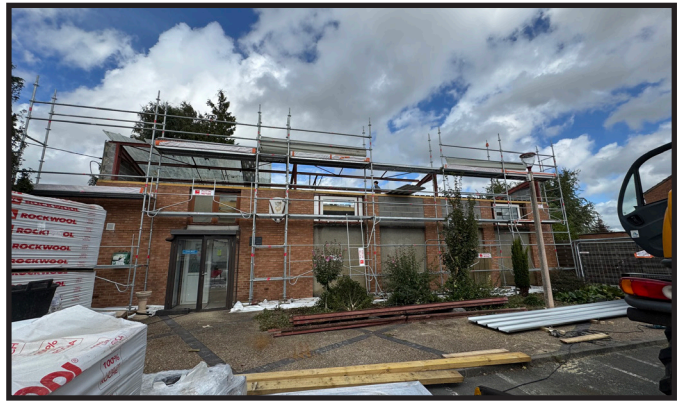
Restauration de la toiture de la salle du billon
