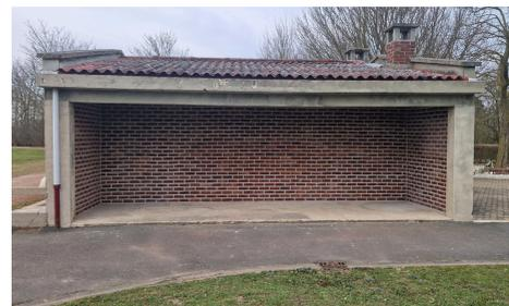
Les travaux de rénovation du bâtiment du cimetière ont eux aussi débuté (nouvelles briquettes et nouvel enduit).
